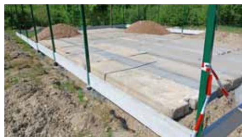
► V Rudolci již finišuje rekonstrukce sběrného místa na odpady. Připraveny jsou již sloupky na nové oplocení, u vstupu do sběrného místa bude umístěna závora.
