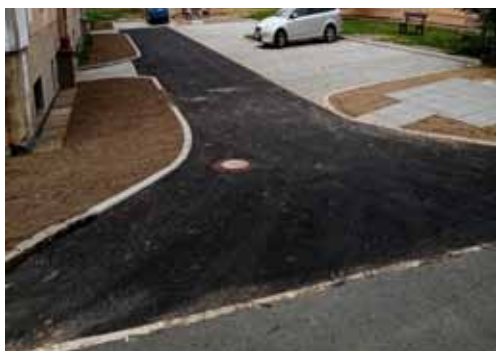
► V ulici Elektrárnská byla dokončena stavební úprava parkovacích ploch před bytovým domem včetně příjezdové komunikace. Samozřejmostí byla i výstavba zpevněných ploch pro posezení. A stejně tak jako u ostatních parkovacích ploch dojde i k osazení zeleně.
