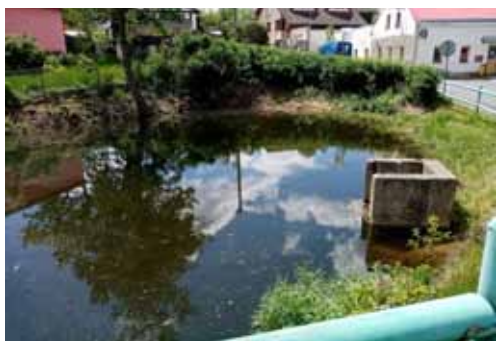
► Opětovně došlo k údržbě rybníčku u restaurace Start. Bylo provedeno odbahnění dna a v hrázi rybníčku došlo k částečnému betonovému zpevnění v místech, kde došlo k průsaku vody mimo propustek. Nyní přepad vody a propustek funguje tak, jak má. Přesto se zpracovává projekt na celkovou revitalizaci této malé vodní nádrže včetně jejího okolí. Uvažuje se i o využití přilehlého pozemku, který je v současné době od města pronajat. Mohl by zde vzniknout např. minipark navazující k vodní ploše. Jedná se však zatím jen o vizi, snahou města bude získat na tento projekt dotaci.
