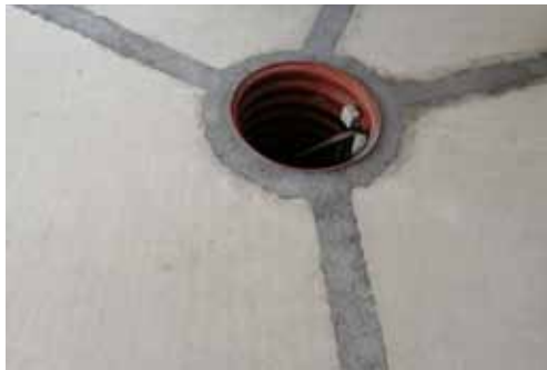
► Opravy v kulturním domě pomalu ale jistě míří do svého finále, byly znovu vystavěny schody, u obličů zdí byly vystavěny předstěny, které budou zajišťovat odvětrávání vlhkosti, v podlaze byla instalována šachta spolu s čerpadlem, které by mělo příp. vodu tekoucí zespodu odčerpávat. V současné době se čeká na dodání nové podlahové krytiny.
