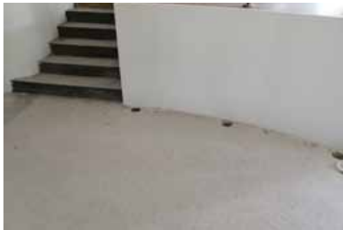
► Opravy v kulturním domě pomalu ale jistě míří do svého finále, byly znovu vystavěny schody, u obličů zdí byly vystavěny předstěny, které budou zajišťovat odvětrávání vlhkosti, v podlaze byla instalována šachta spolu s čerpadlem, které by mělo příp. vodu tekoucí zespodu odčerpávat. V současné době se čeká na dodání nové podlahové krytiny.
