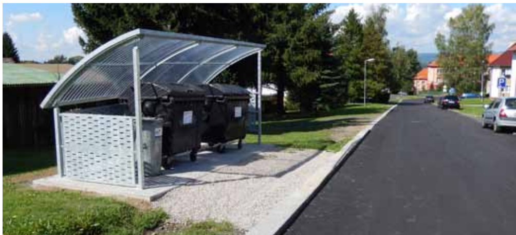
► V ULICÍCH, KDE DOŠLO K OPRAVĚ POVRCHU KOMUNIKACE, DOCHÁZÍ V SOUČASNÉ DOBĚ I KE ZŘÍZENÍ NOVÝCH PŘÍSTŘEŠKŮ PRO KONTEJNERY. NÁSLEDNĚ DOJDE K VÝMĚNĚ STÁVAJÍCÍCH POPELNIC ZA KONTEJNERY.
