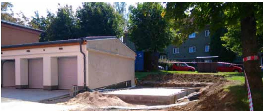
► V SRPNU BYLO ZAPOČATO S VÝSTAVBOU NOVÉ GARÁŽE ZA BUDOVOU RADNICE, A TO Z DŮVODU POŘÍZENÍ NOVÉHO, VĚTŠÍHO SLUŽEBNÍHO VOZIDLA.
