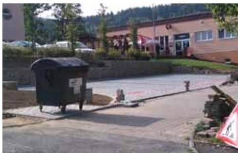
► VYBUDOVÁNO BYLO NOVÉ PARKOVIŠTĚ POD MFC
