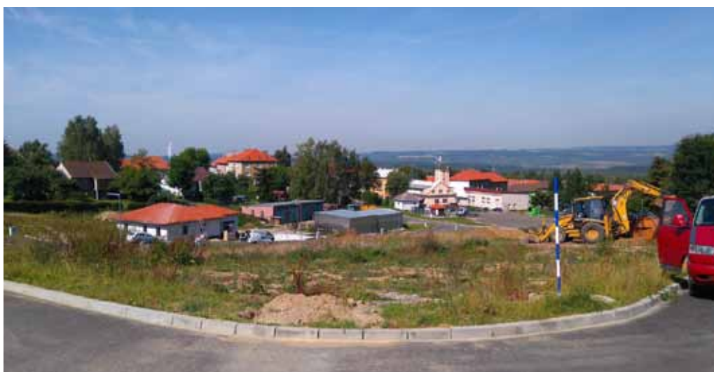
► NA VÝSLUNÍ SE JIŽ NĚKTEŘÍ NOVOPEČENÍ MAJITELÉ STAVEBNÍCH PARCEL PUSTILI ČILE DO VÝSTAVBY
